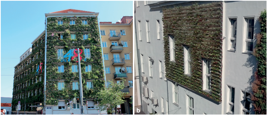
Abb. 6. Fassadengebundene Begrünungssysteme mit horizontal angebrachten Aluminiumträgern; a: MA-48-Haus, Wien, begrünte Fassadenfläche: 850 m 2 , b: Schule GRG 7 Kandlgasse, Wien, begrünte Fläche: 58 m 2 . – Fotos: TU Wien, 2019.
