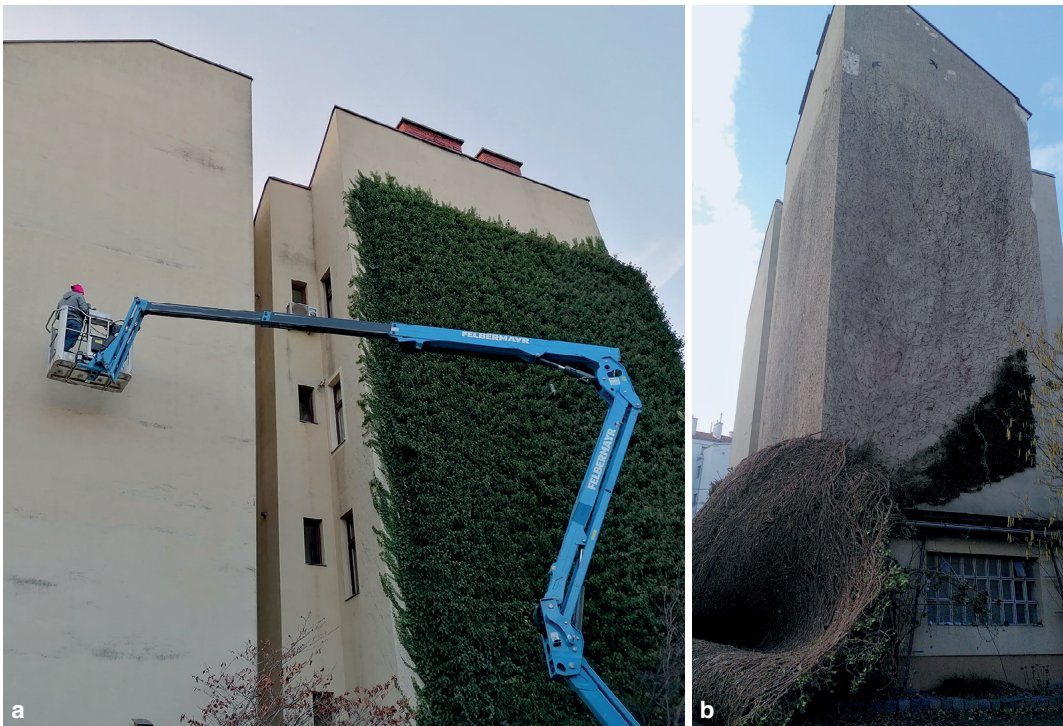
Abb. 7. Bodengebundene Fassadenbegrünung mit Efeu, Kopalngasse, Wien; a: Anbringung der Sensoren zur Messung der U-Werte, b: Zusammenbruch der Efeubegrünung nach einem starken Gewitter. – Fotos: TU Wien, a: 2021, b: 2023.
