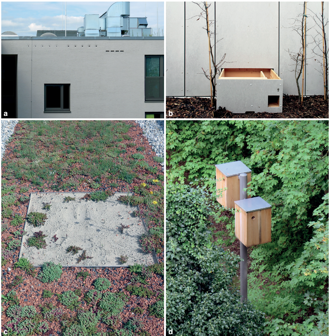
Abb. 5. Maßnahmen zur Förderung von Zielarten gemäß dem Animal-Aided Design bei einer Nachverdichtung im Projekt Brantstraße in München; a: Niststeine für Sperlinge (links), Mauersegler (mitte) und Quartiere für Fledermäuse (rechts), integriert in die Fassade; b: Schublade zum Überwintern von Igel, integriert in einen Geräteschuppen (zur Wartung geöffnet); c: Staubbad für Sperlinge, integriert in die Dachbegrünung der Geräteschuppen; d: »Spechtlaterne« als Nisthilfe für Grünspechte. – Fotos aus Weisser & Hauck (2023).
