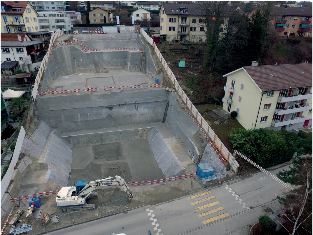
Abb. 6. Blick in eine ausbetonierte Baugrube auf Parzellengröße im Kanton Zürich (Baugrube ÜB Risi, Oberengstringen). – © Schläpfer & Partner AG ( www.sping.ch )
