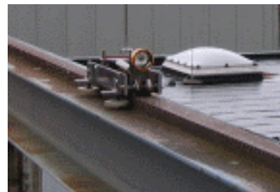
(b) Kranbahnmesswagen der Firma Trigis Geoservices GmbH (TRIGIS, 2017).
