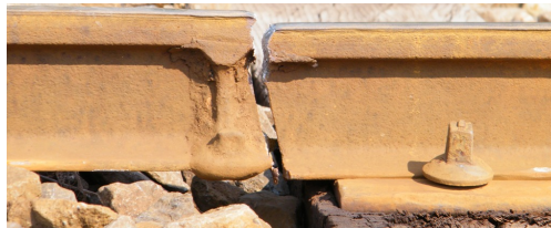
Abbildung 4.4: gebrochener Schienenstoß (Wikipedia, 2013)
