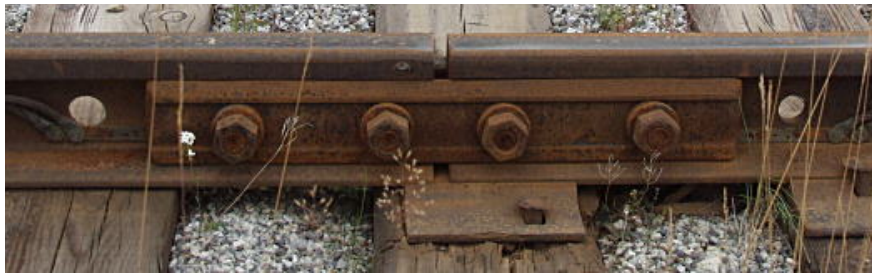
Abbildung 2.11: Durch Laschen verbundene Schienen (Reinmuth, 2013).
