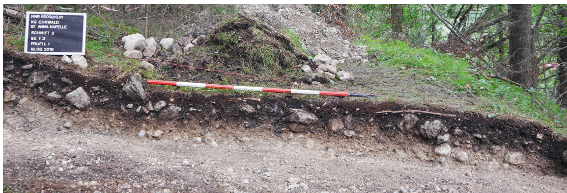
Abb. 5. Ehrwald, Loisachtal. Das Profil durch die Wegtrasse zeigt, dass der anstehende Schotter eingeebnet wurde.
