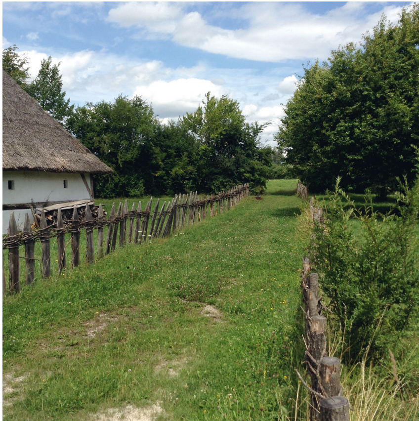
Abb. 8. Fränkisches Freilandmuseum Bad Windsheim, Baugruppe Mittelalter. Rekonstruierter Zaun aus Spaltbohlen, stabilisiert durch Rutengeflecht.
