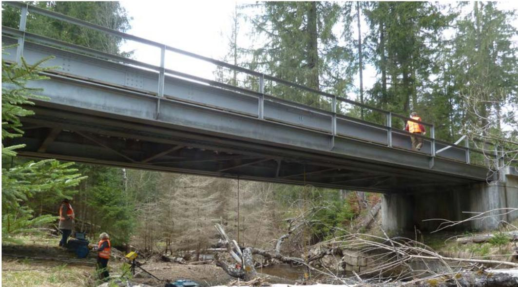
**Abb. 93.a.:** Seitenansicht der Einfeldträgerbrücke.
