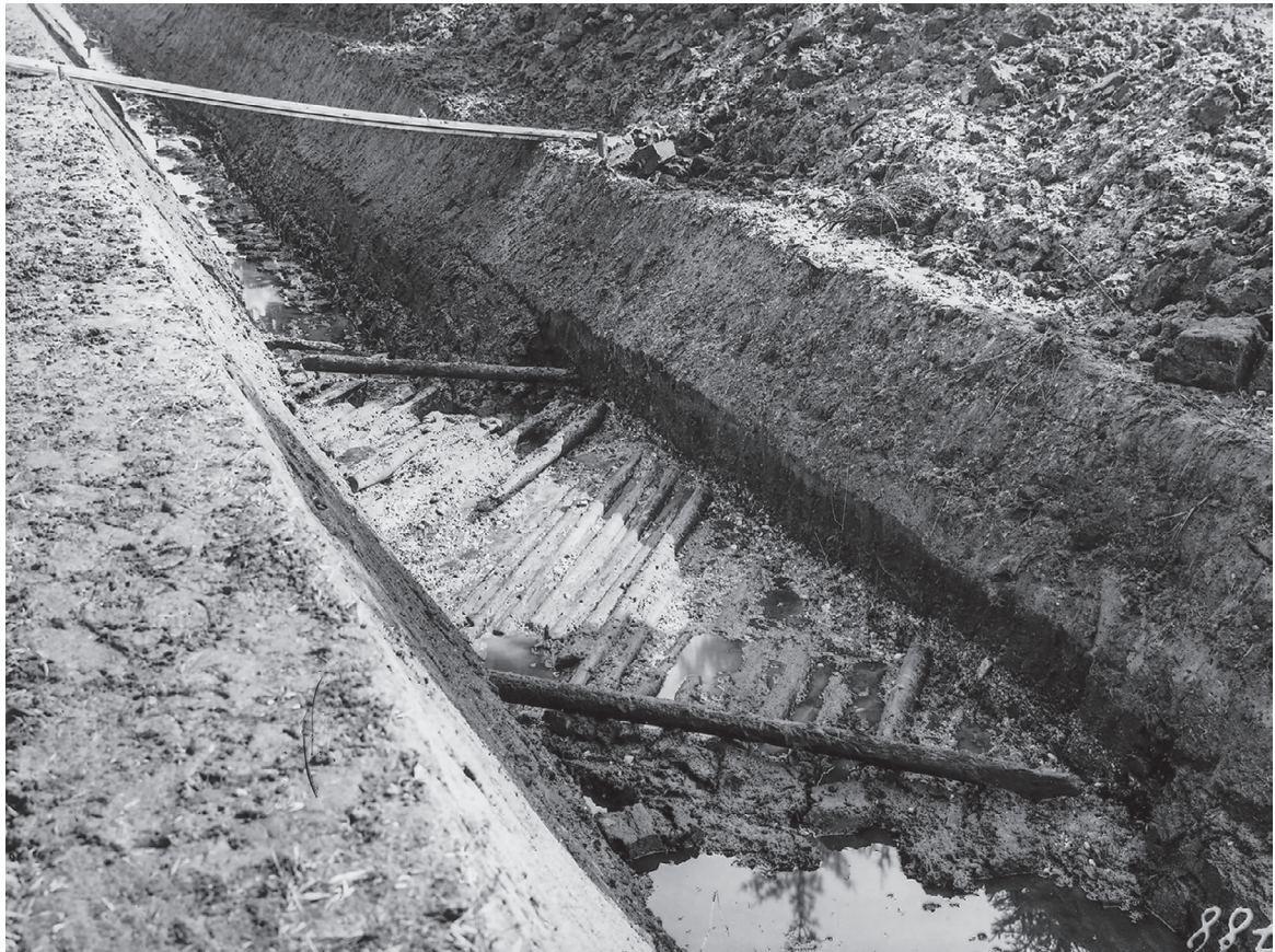
Abb. 6. Eschenloher Moos. Drainagegraben 1934. Aufdeckung der römertimeiligen Holz-Kies-Straße im Juli 1934. Aufnahmen vom Reichsarbeitsdienst nach Entfernung der Kiesschüttung, die im Profil noch gut zu erkennen ist. Blick nach Nordosten.
