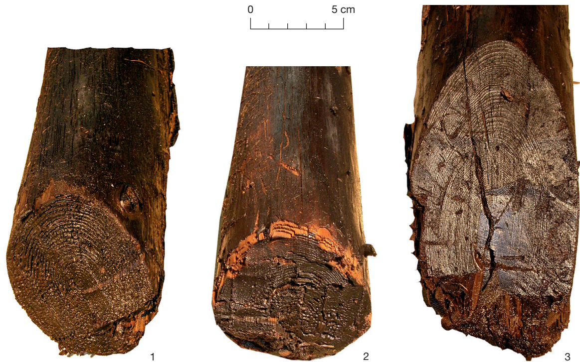
Abb. 8. Bearbeitungsspuren von Hölzern der römischen Straße im Eschenloher Moos. 1 Holz Q125. Bearbeitetes Ende von Weißtannenstangenholz. – 2 Holz Q124. Bearbeitetes Ende von Fichtenstangenholz. – 3 Holz Q005. Bearbeitetes Ende von Weißtannenstangenholz. – M. 1:2.
