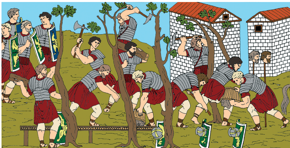
Abb. 11. Umzeichnung eines Reliefs der Trajanssäule in Rom. Dargestellt sind römische Legionare während des ersten Dakerkriegs 101/102 n. Chr. beim Bau einer Brücke oder Holz-Kies-Straße durch Sumpf und Wald: zwei bereiten die Oberfläche vor, drei fällen mit Äxten Bäume, zwei tragen Stammabschnitte herbei, zwei schütten aus Körben Erde, Sand oder Kies auf den Boden und auf die bereits fertiggestellte Holzunterlage; Helme und Schilde sind in der Nähe griffbereit abgelegt.
