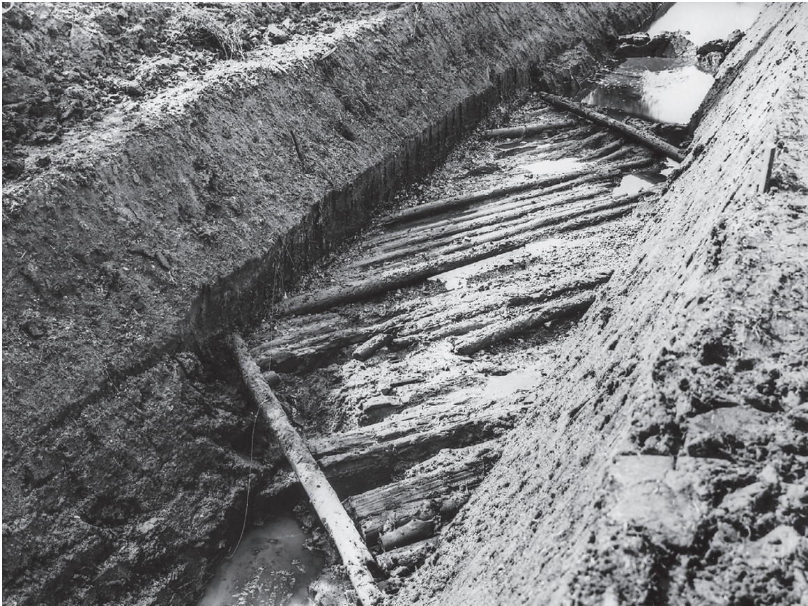
Abb. 7. Eschenloher Moos. Drainagegraben 1934. Aufdeckung der römertimeitlichen Holz-Kies-Straße im Juli 1934. Aufnahmen vom Reichsarbeitsdienst nach Entfernung der Kiesschüttung, die im Profil noch gut zu erkennen ist. Blick nach Süden.
