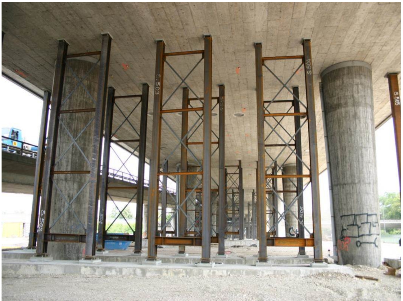
Abbildung 6.16: Provisorische Abstützung des Überbaus für die Trennung des Überbaus in zwei Hälften und den Rückbau
