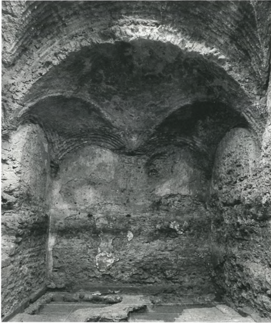
Abb. 4. Karthago, Kobbat Bent el Rey, Hauptraum Kompartiment Süd. Trompengewölbe aus drei halben Hängewölben von Norden.
