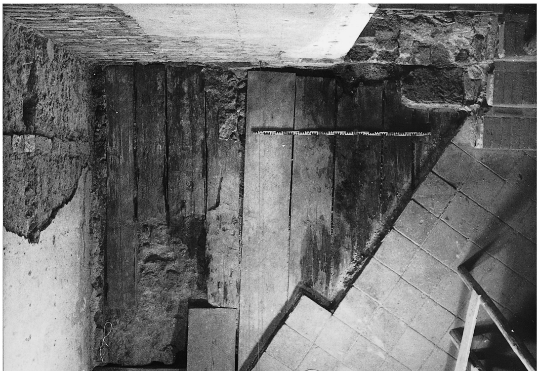
Frauenwörth, Torhalle, Schnitt „Marienaltar“ im Saal der Michaelskapelle, Ostteil. – 1 Dielenboden III mit Mörtelbett am Standort des Altares; 2 nach S erweiterter Schnitt mit freiliegendem Lagerbalken 2 und estrichartiger Oberfläche der östlichen Gewölbetonne (Boden I?) und Mörtelbett einer Stufe vor der Ostwand; 3 Boden III nach Wegnahme der Mörtelauflage. – N links.
