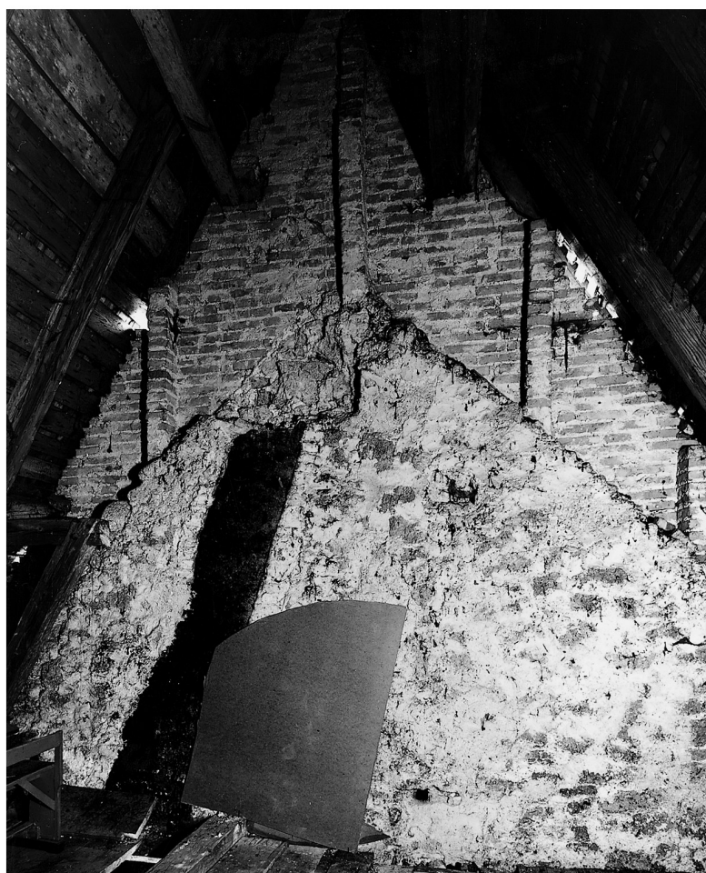
Frauenwörth, Torhalle. – 1 Östliche Giebelwand des Chores nach Ausbau der spätmittelalterlichen Gewölbedecke; 2 Ostgiebel des Langhauses mit jüngerer Backsteinaufmauerung.
