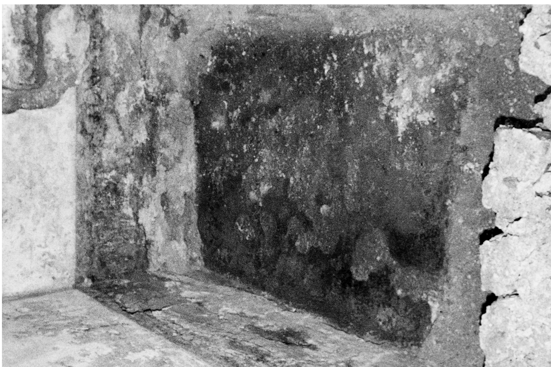
Frauenwörth, Torhalle, Schnitt 3 in der Ostarkade im Erdgeschoß. Reste eines teilweise abgebauten zerstückelten Estrichs mit roter Farbauflage, die Wand in den untersten Zonen verputzt, im Vordergrund Backsteinboden 3, darüber an der Wand Plattenboden 4; von NW (1) bzw. N (2).
