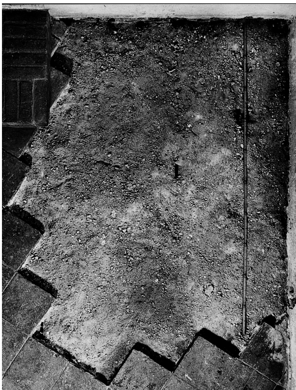
Frauenwörth, Torhalle, Schnitt „Christusaltar“ im Saal der Michaelskapelle. – 1 Plattenboden V und Ausflickung mit Backsteinen (Va); 2 Mörtelbett des Bodens V/Va; 3 Unterlage des Mörtelbettes; 4 Bohlenboden III mit anhaftenden Kalkmörtelresten. – N links.
