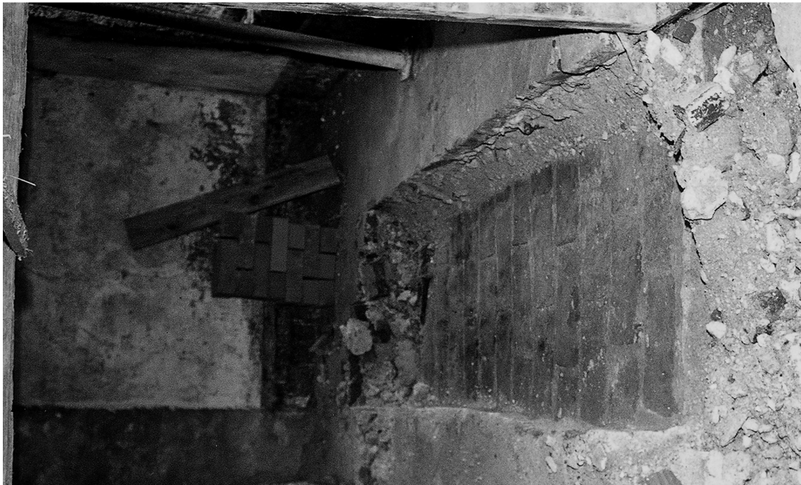
Frauenwörth, Torhalle, Schnitt 3 in der Ostarkade im Erdgeschoß. – 1 Backsteinboden (3), von W, links im Hintergrund Wandanschluß der bereits entfernten Nordwand des „Beinhauses“; 2 Boden 3 von N, im Vordergrund Plattenboden 4, daran anschließend Fußbodenkante (Backsteine) zur abgebrochenen Innenwand.
