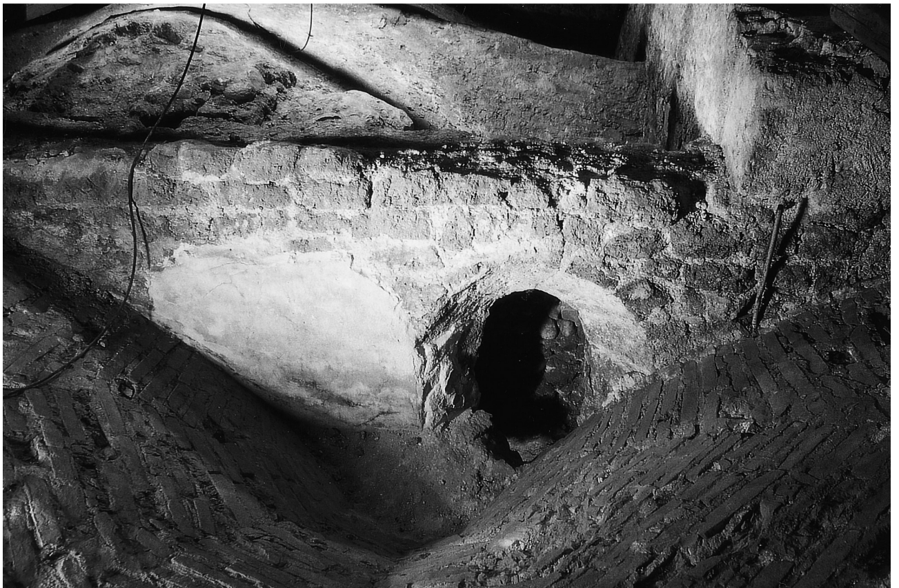
Frauenwörth, Münster. Ausschnitt im Dachgeschoß der Nordvorhalle mit Rundbogenfenster des Seitenschiffs. – 1 Außenseite mit Putzresten in der Fensterlaibung; 2 Innenseite des Seitenschiffensters mit Wandputz.
