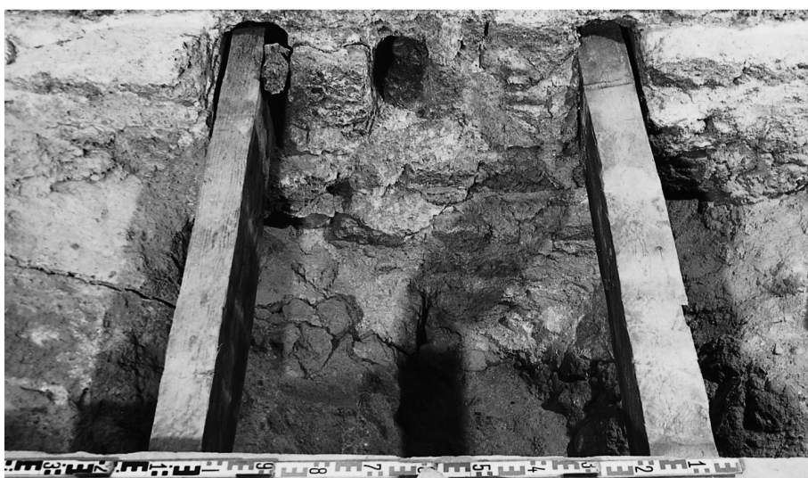
Frauenwörth, Torhalle, südliche Saalwand der Michaelskapelle. – 1.2 Balkenlöcher 2 u. 3 und darin ruhender Lagerbalken 2 des Bodens III; 3 Balkenlöcher 2–4 im Zwickel zwischen östlicher und mittlerer Gewölbetonne.
