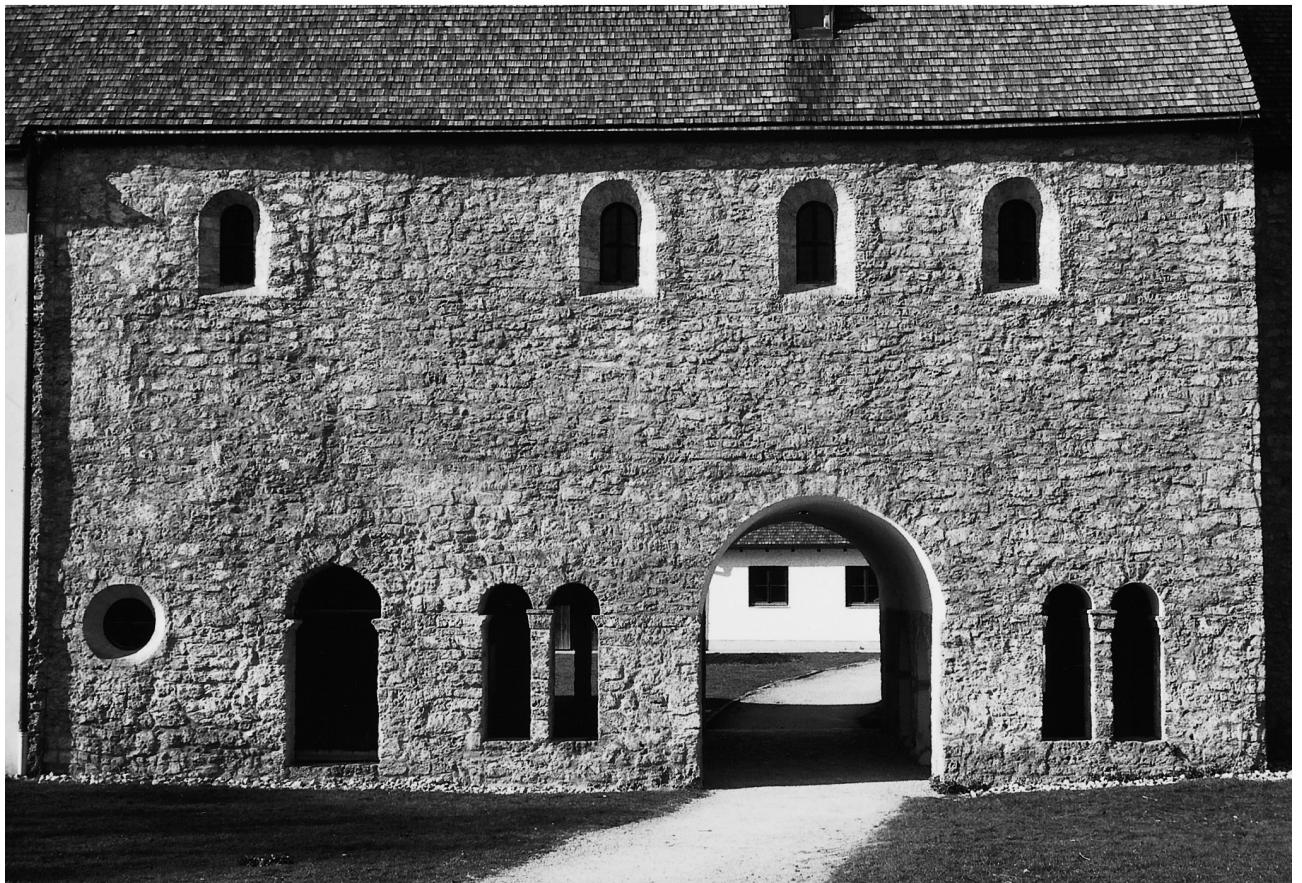
Frauenwörth, Torhalle und Vikarhaus, Südseite. – 1 Zustand während der Bauuntersuchungen (1963); 2 Mauerstruktur und Wandöffnungen des Torbaues nach der Rückrestaurierung (Aufnahme 2004).
