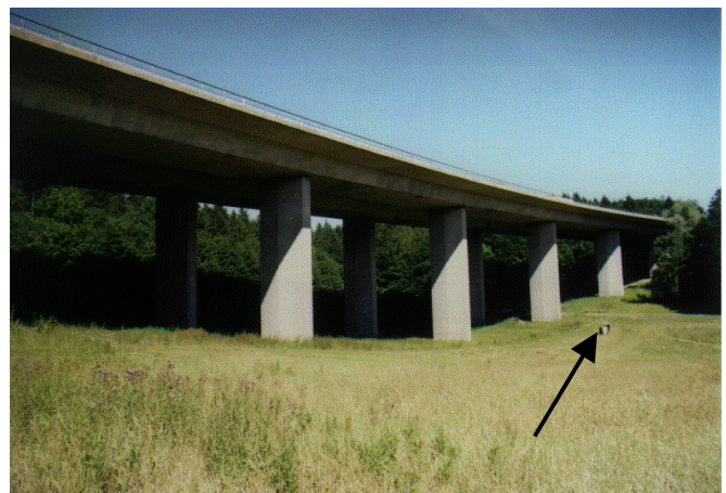
Abb. 12: Instrumentenstandpunkt (mit Pfeil gekennzeichnet)
