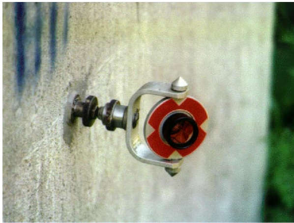
Abb. 11: Signalisierter Festpunkt am Pfeiler
