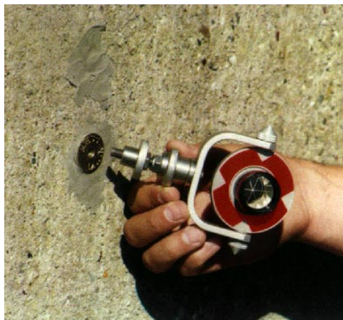
Abb. 14: Festpunkt im Pfeiler
