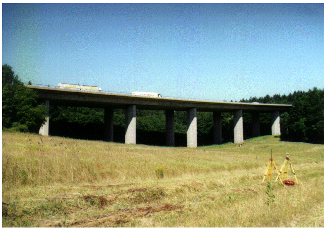
Abb. 38: lokale Referenzstation in Brückennähe auf Festpunkt
