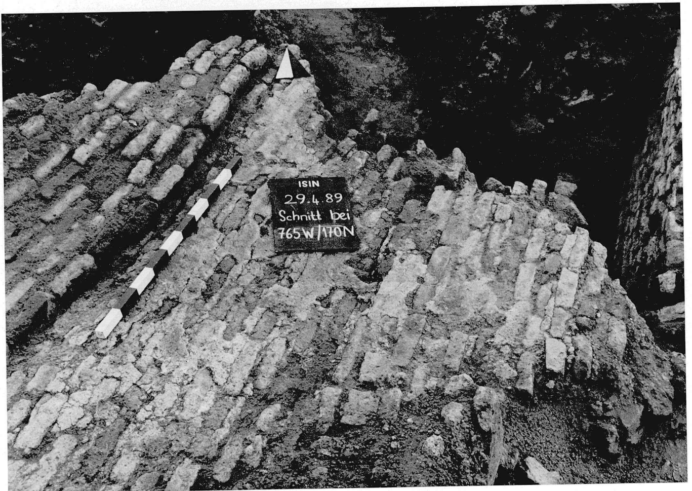
2 Sog. Kastell, eingestürztes Mauerwerk
