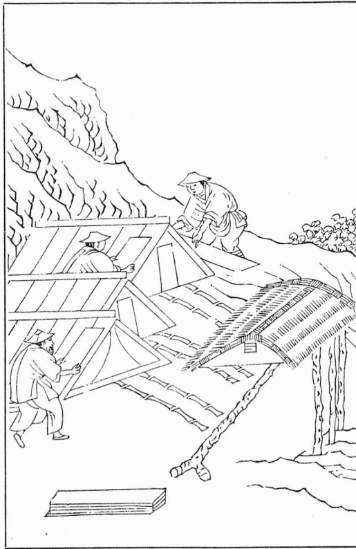
Abb. 2: Bau des Ofens ( Mo-p'u 1,2a)
