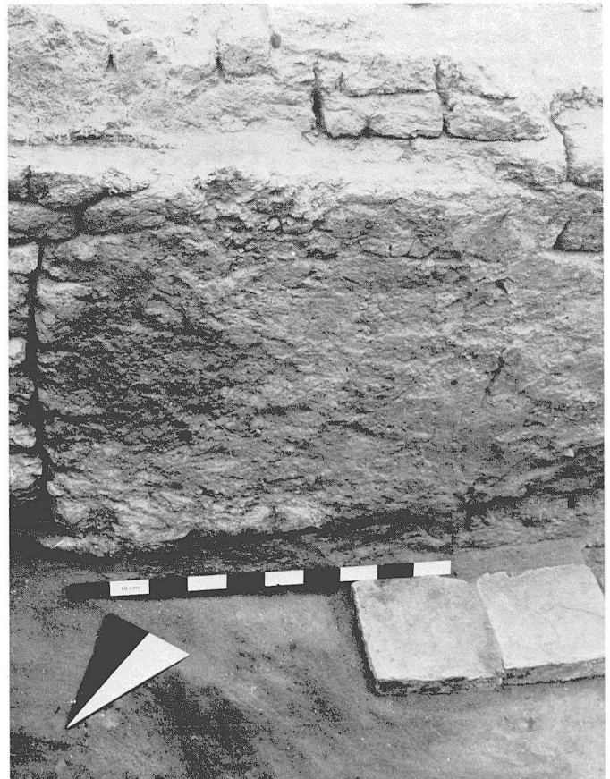
4 = Raum 4, links zugesetzte Tür nach Raum 9
