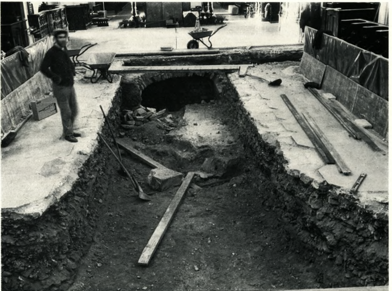
b Grabung für die Heizung im Ostchor. 24. 11. 1970. Blick nach W. zur Vierung. Vor der geöffneten „Luftkammer“ das Mauerwerk des Apsisansatzes.
