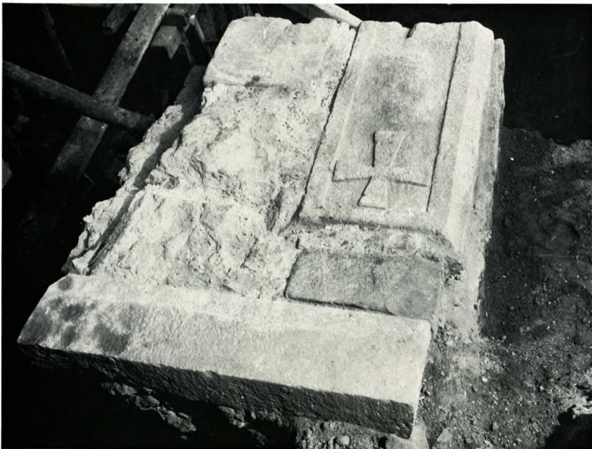
b Plinthe unter dem mittleren Pfeiler (Pf. II) nach dem Abbauen des Sockels, von W.
