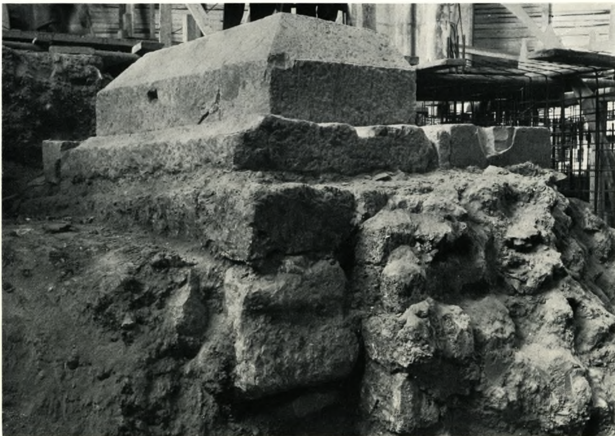
a Mittlerer Pfeiler (Pf. II) von SO auf der Längsmauer (c). Der Nordteil des Pfeilers und der Ostteil der Mauer sind bereits abgebrochen.
