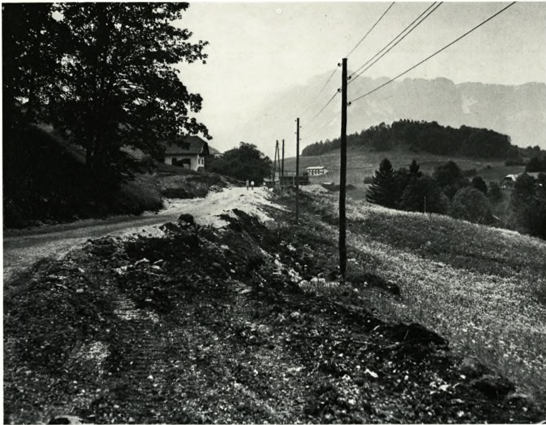
1 Blick nach Westen auf die Hofgasse und den mittleren und westlichen Teil der Terrasse des Eislfelds.
