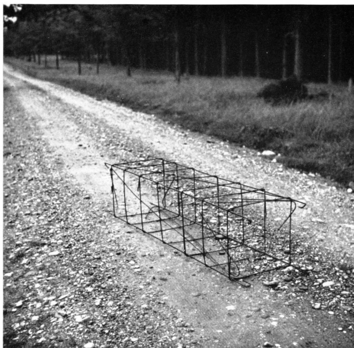
Fig. 3. Drahtkorb für Pfeilerbau
