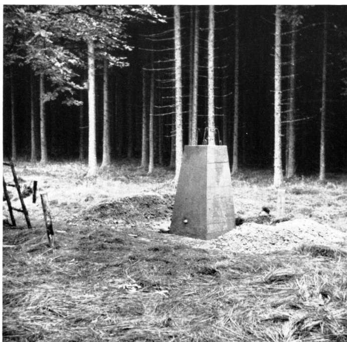
Fig. 10. Interferenzpfeiler 600 im Bau
