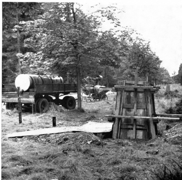
Fig. 4. Interferenzpfeiler 432 im Bau
