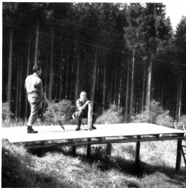
Fig. 13. Längerer 24-m-Pfahl mit Jäderinzapfen und Podest in geringer Höhe
