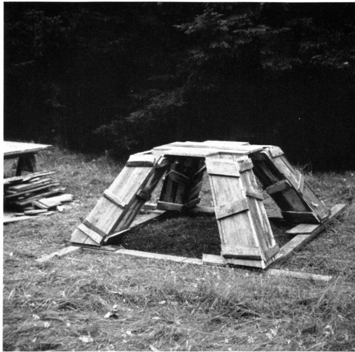
Fig. 5. Verschalung für Dittrichsche Festlegung
