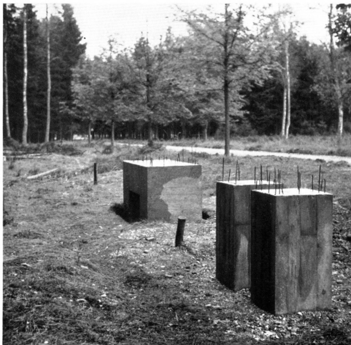
Fig. 6. Pfeiler o-4, 5, 6 (Nord) im Bau
