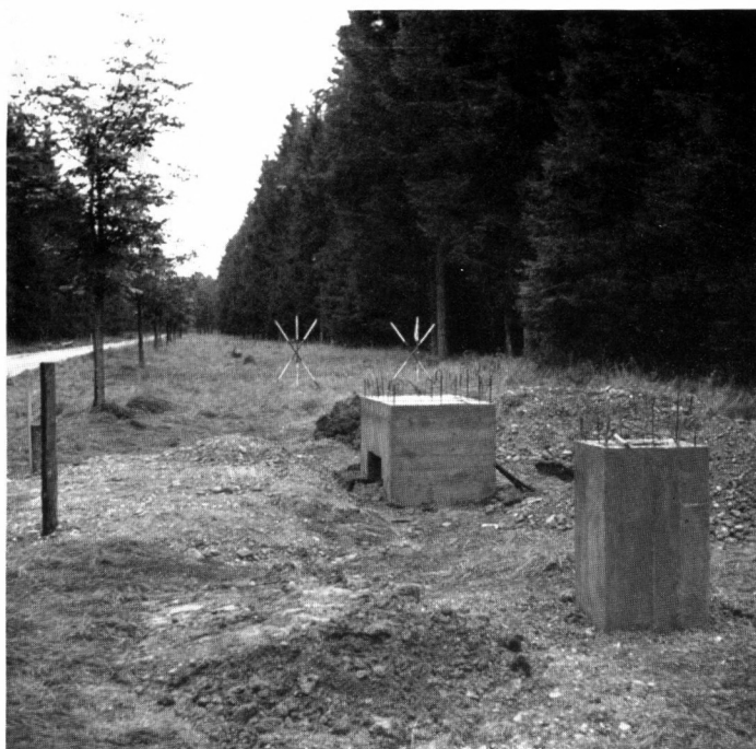
Fig. 9. Pfeiler o-1, 6 (Süd) im Bau
