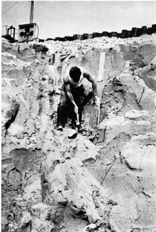
Abb. 1 Einbringen eines Entnahmekastens
