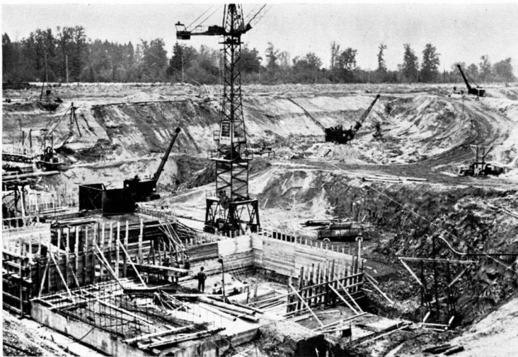
Abb. 2 Baugrube der Innstaustufe Rosenheim
