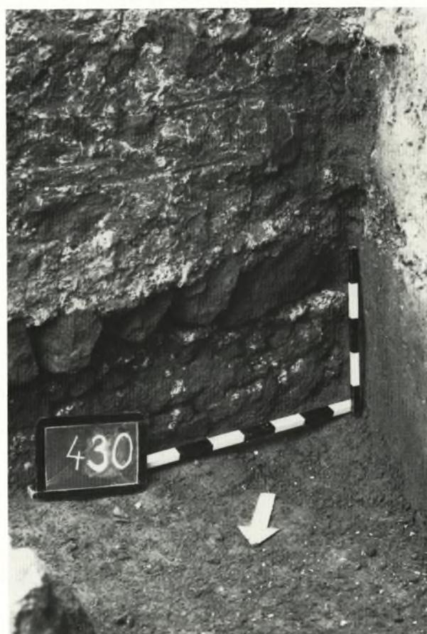
Abb. 18. Burg Sponeck. – Ostmauer, Innenseite. Das überkragende Mauerwerk mit den Resten von Fugenstrich.
