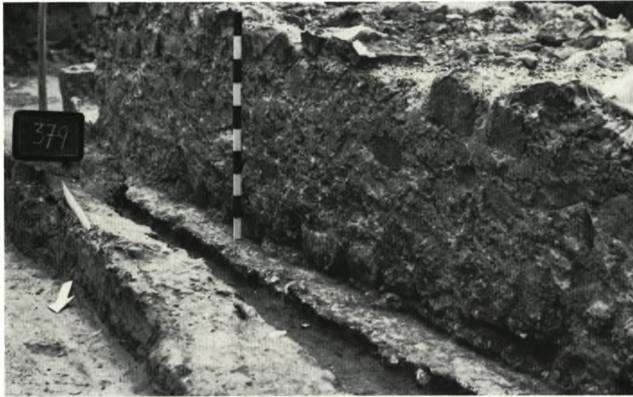
Abb. 27. Burg Sponeck. – Turm 3. Nordostmauer. Außenseite. Vor der Mauer das gestörte Arbeitsniveau.
