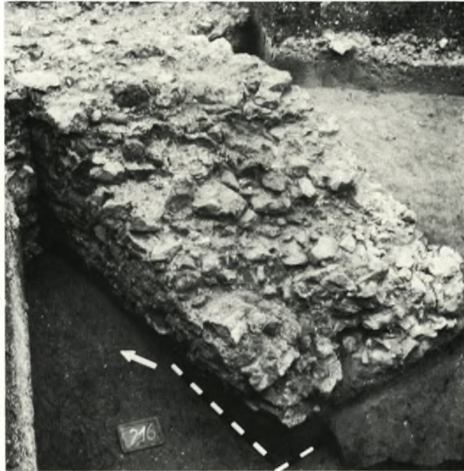
Abb. 12. Burg Sponeck. – Abgebrochene, von Turm 2 südwärts gerichtete Mauer; links die Gleitfuge.
