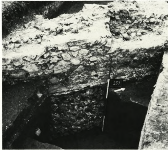
Abb. 14. Burg Sponeck. – Ostmauer von Osten.
