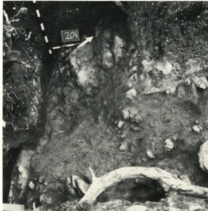
Abb. 6. Burg Sponeck. – Abgebrochener Felshang westlich an Turm 1 anschließend.
