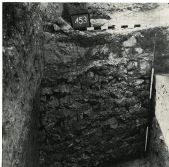
Abb. 9. Burg Sponeck. – Fundament der Südwestmauer von Norden.
