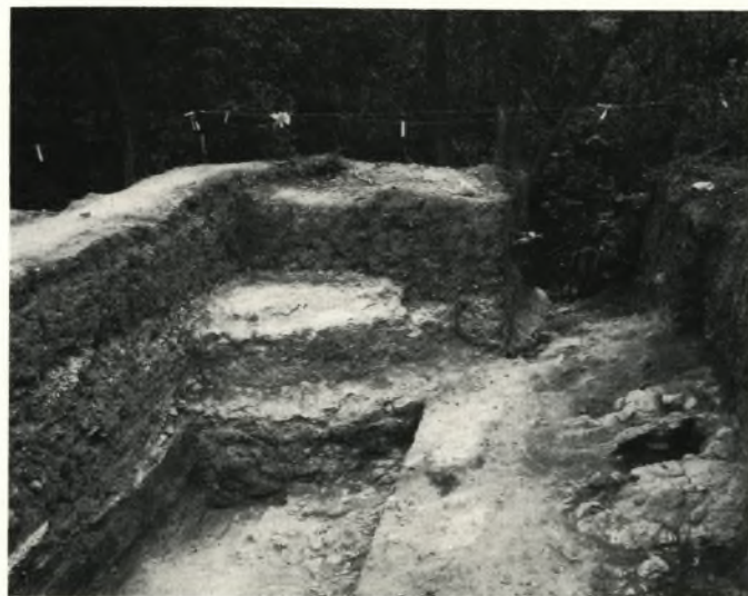
Abb. 7. Burg Sponeck. – Turm 1 mit dem in den Fels eingelassenen Fundament (rechts); links im Profil die Lößlage.
