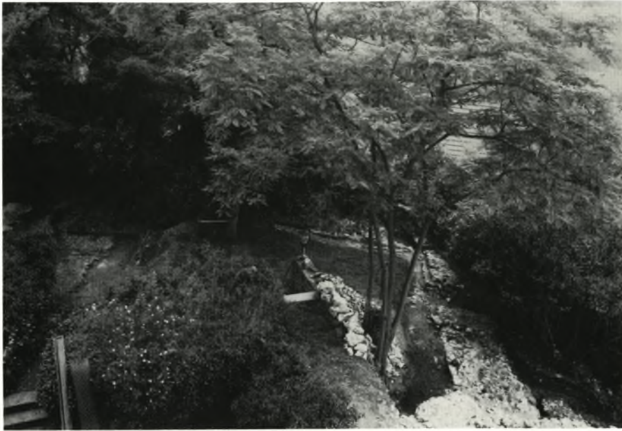
Abb. 44. Burg Sponeck. – Burghügel. Reste römischer Mauern.
