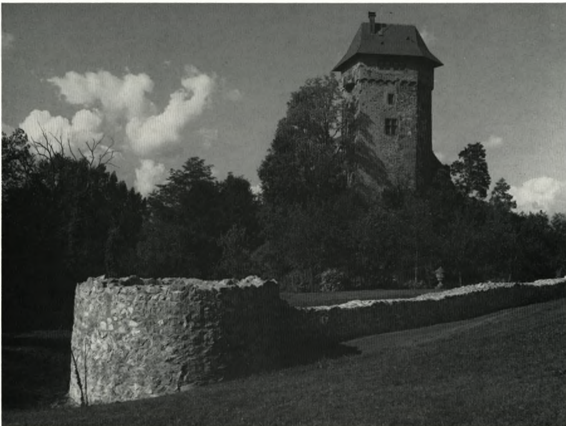
Abb. 50. Burg Sponeck. – Turm 2 mit Ostmauer nach der Konservierung von Südosten.
