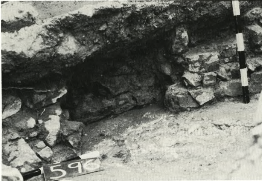
Abb. 41. Burg Sponeck. – Burghügel. Ältere Mauer unter dem heutigen Turmaufgang. Reste von Estrich ziehen unter diese Mauer.
