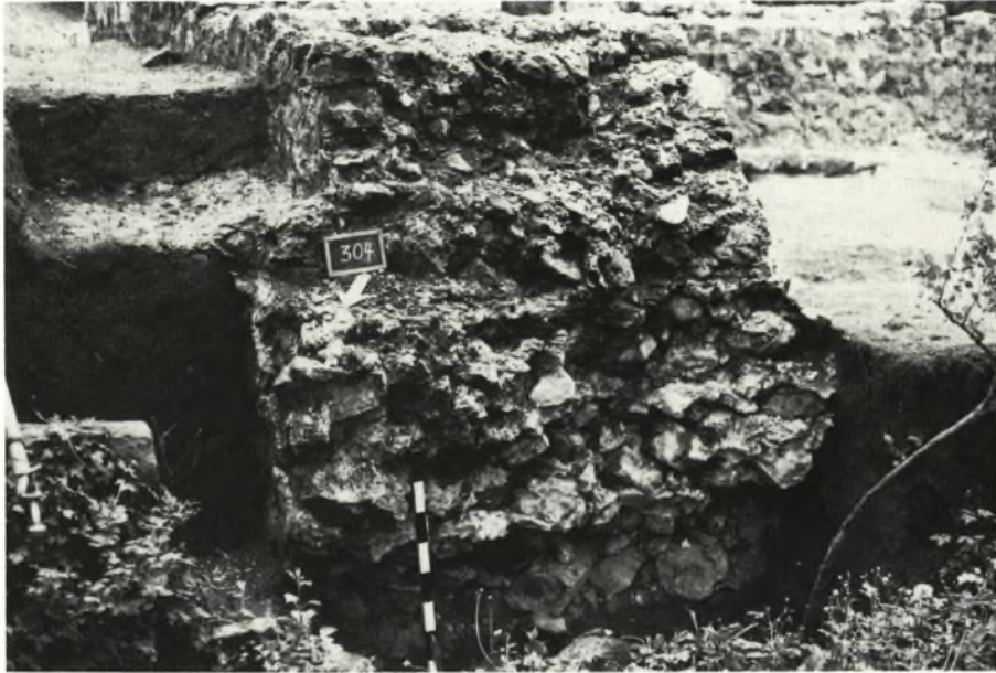
Abb. 20. Burg Sponeck. – Turm 3. Abgebrochene Nordecke.
