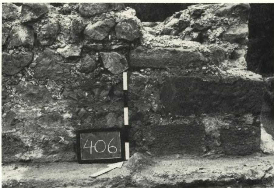
Abb. 23. Burg Sponeck. – Turm 3. Ostecke mit den kreuzverlegten Buntsandsteinquadern.
