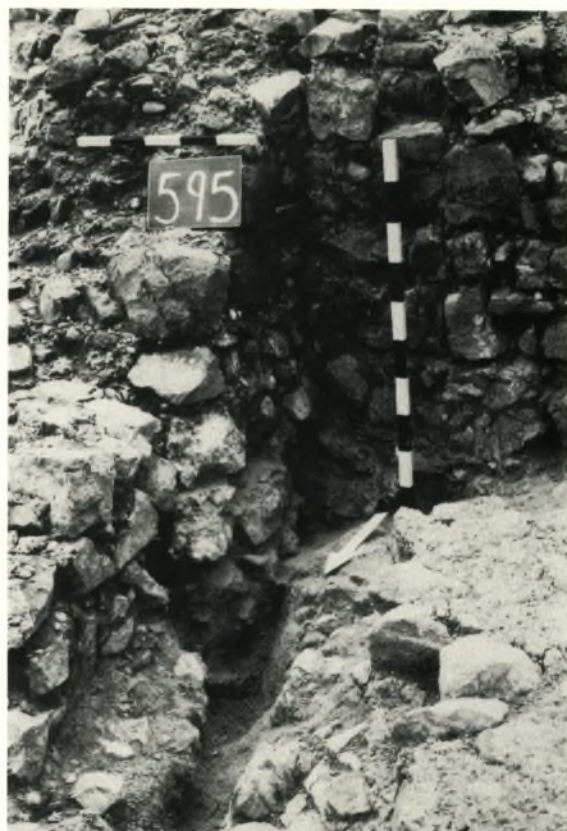
Abb. 46. Burg Sponeck. – Burghügel. 1 Mit Mörtel gefüllte Spalte zwischen der älteren rechten und der jüngeren linken Mauer; 2 Abgearbeitete Felskante nach Entfernen der Mörteldecke.
