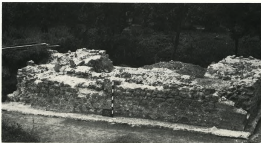
Abb. 22. Burg Sponeck. – Turm 3. Links die ausgebrochene Südecke, rechts die mit Buntsandsteinquadern verstärkte Ostecke.
