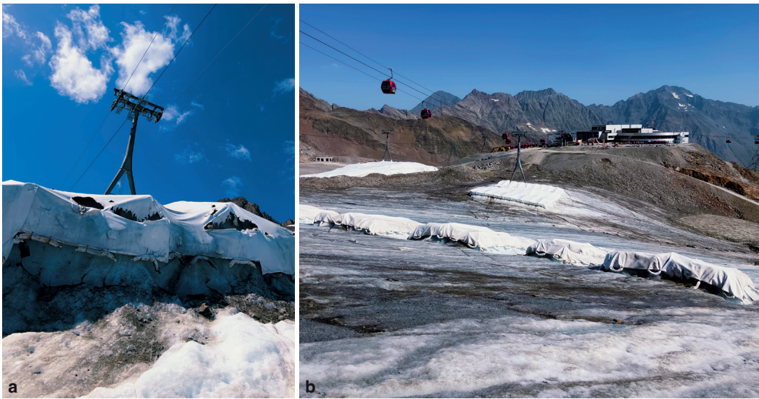
Abb. 4. Gletscherschutz mit Polypropylenvliesen, Stubaier Gletscher, Ötztal, a: zur Stabilisierung einer Liftstützenverankerung; b: großflächige Abdeckung. – Fotos: Birgit Sattler.
