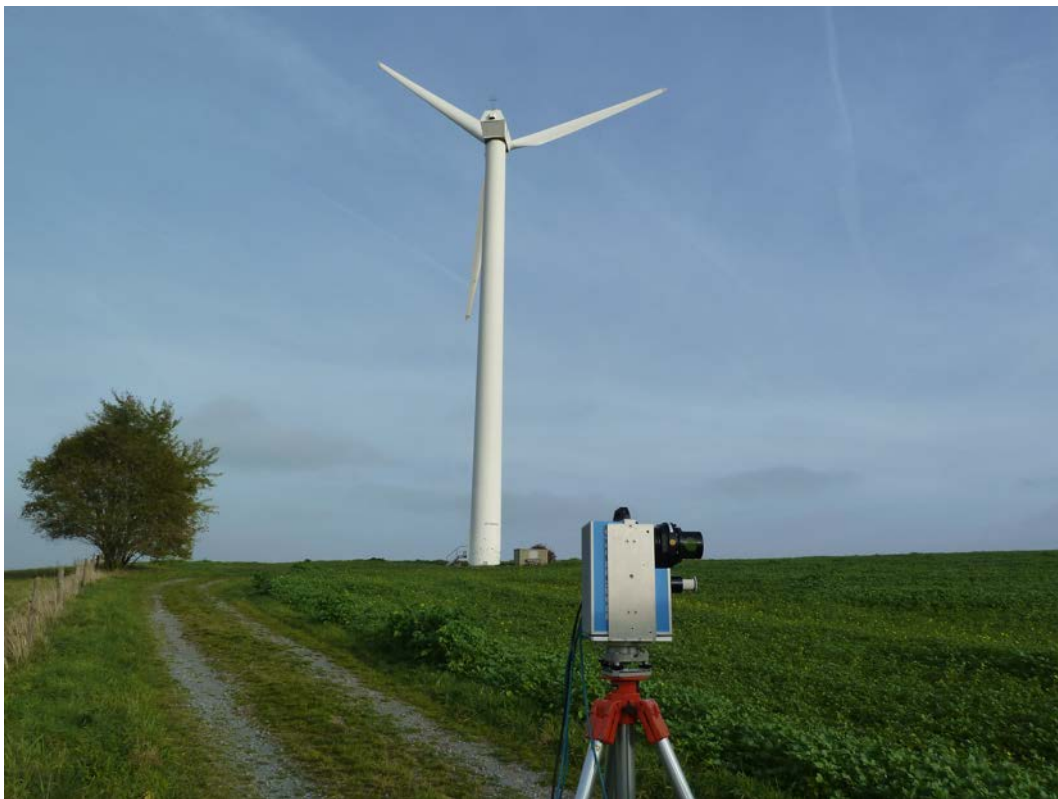
Abb. 131.: Windenergieanlage Tacke TW600.
