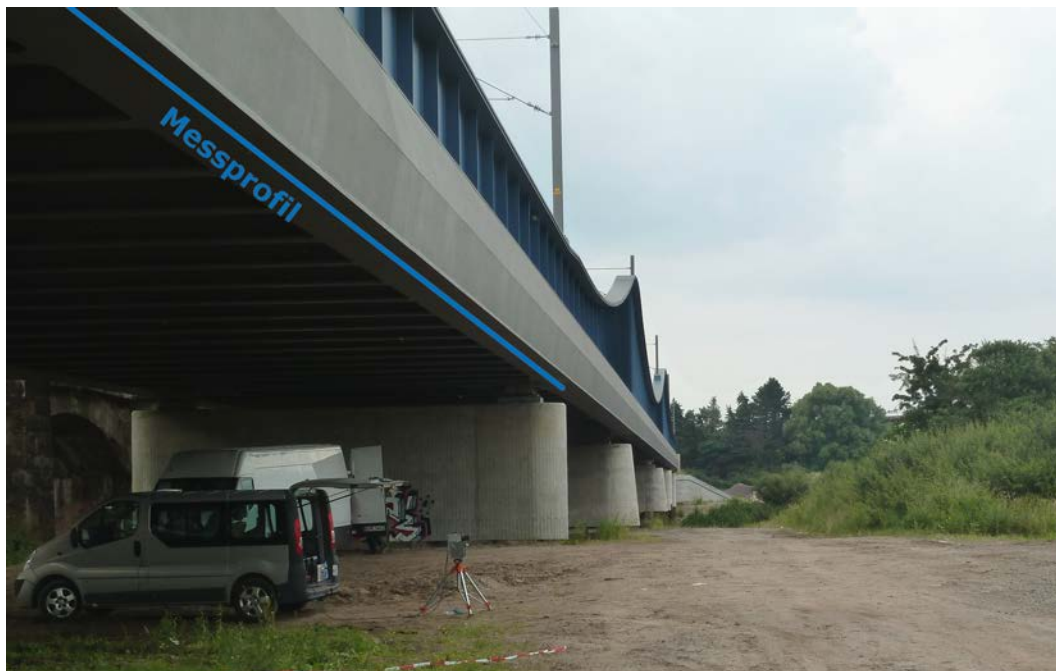
Abb. 124.: Neue Trogbrücke über die Aller.
