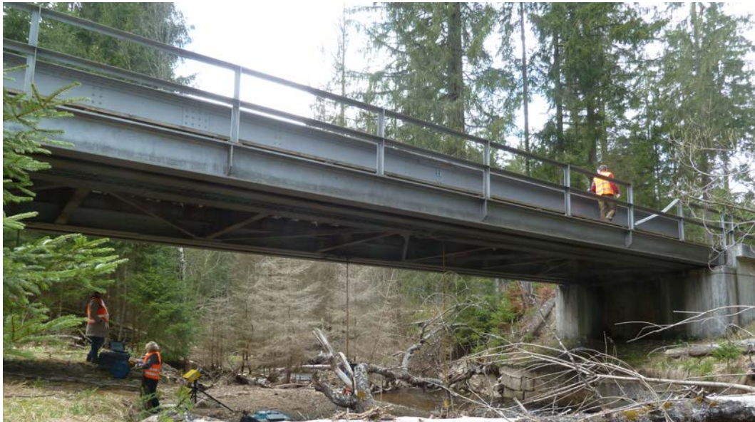
Abb. 93.a.: Seitenansicht der Einfeldträgerbrücke.
