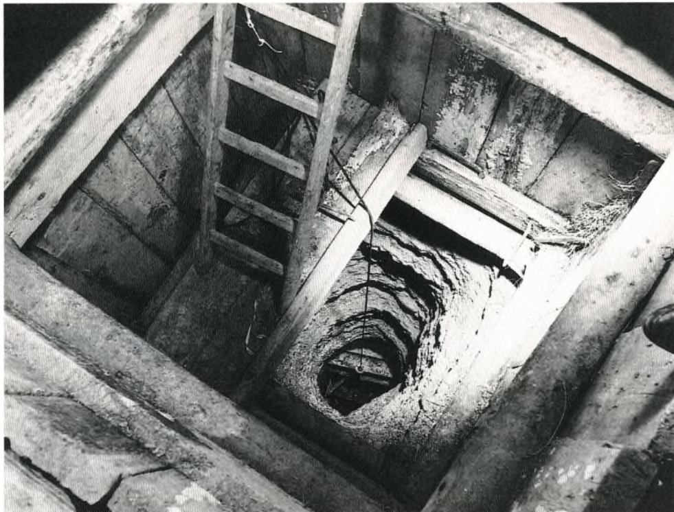
2 Holzhausen, Viereckschanze 2. Schacht 3 (Nordostschacht). Die kleinere Arbeitsverschalung im obersten Teil der Nagelfluh und Blick in den während des ersten Grabungsabschnittes unverschalt gebliebenen Schachtabschnitt.
