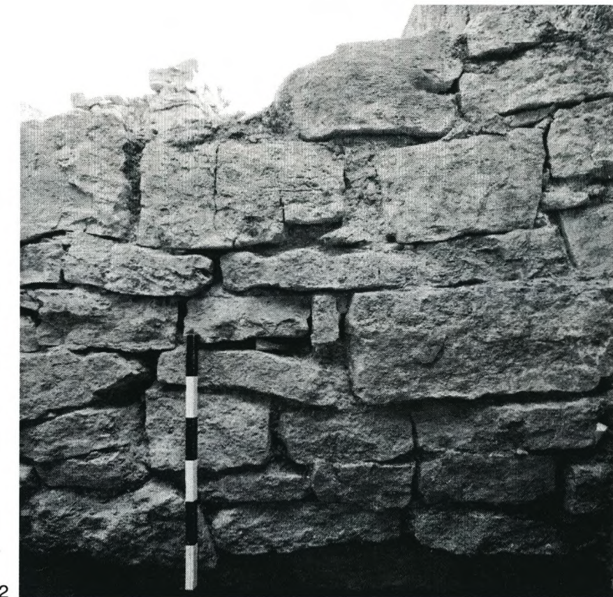
Karlburg – Burg. 1 Fläche 3, Frontmauer und Nordostecke von Turm 1. – 2 Fläche 3, Außenansicht der Frontmauer von Turm 1.
