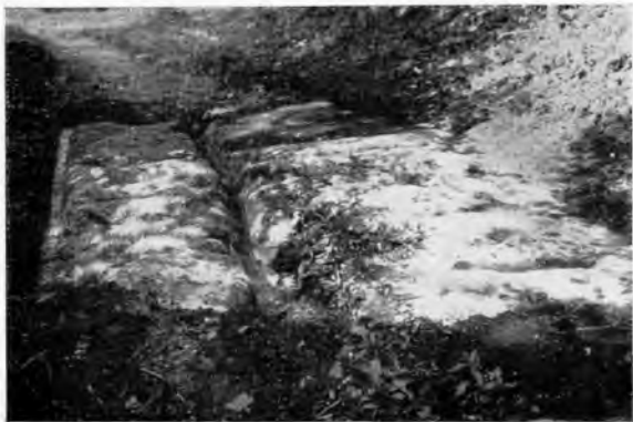
22. Federauner Sattel . Tiefer Einschnitt D, von Süd. Breite Geh- bahn mit Trittrillen. (Taf. 16 Profil c).
