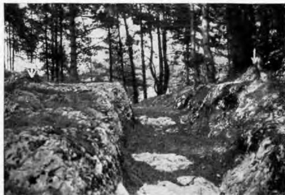
34. Federauner Sattel. Geleiseeinschnitt bei P. Beiderseits höher ältere Straße; Rand- böschungen (Pfeile).
