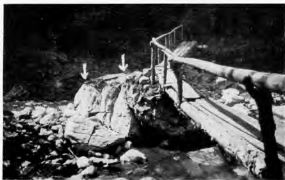
44. Holzsteg über den Angerbach beim Heldenfriedhof. Mörtellager für römische Balkenbrücke (Pfeile).
