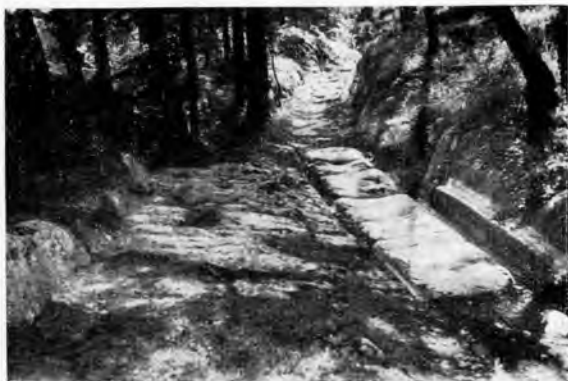
27. Federauner Sattel. Nordostabstieg bei L. Rillengeleise = Abb. 24, 25. Links höher liegend ältere Straße, Trittstufen, Rand- böschung (Taf. 16 Profil o).
