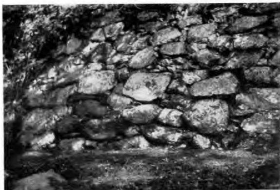
49. Stützmauer am Veneterweg in der Hinterraud (unteres Valterintal)
