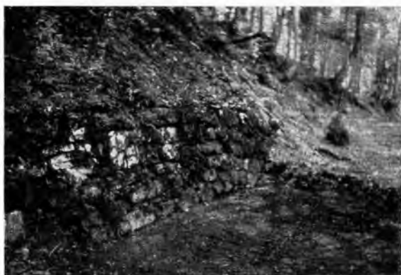
50. Stützmauer am Veneterweg; am Fuß alter Straßenestrich.
