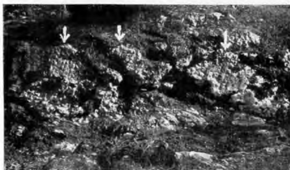
32. Federauner Sattel . Meißelspuren am Böschungrand der äl- teren Straße, Abb. 31.
