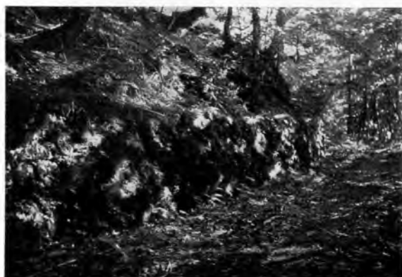
51. Stützmauer am Veneterweg mit heutiger Bewachung.
