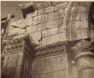
Abb. 12. Qal'at Sem'an. Südfassade, Detail (1926).
