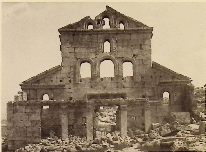
Abb. 33. Bāqirhā. Ostkirche, Westfassade (1956).
